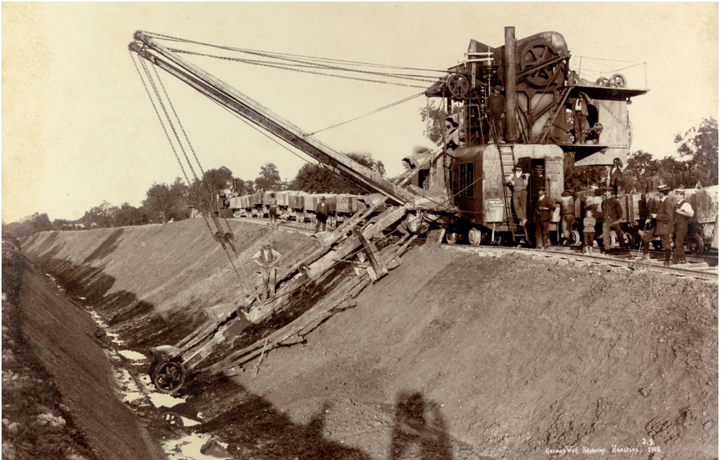
Solche schweren Maschinen waren damals eine Seltenheit: Aushubmaschine beim Bau der Bodensee-Toggenburg-Bahn im Jahr 1908.
